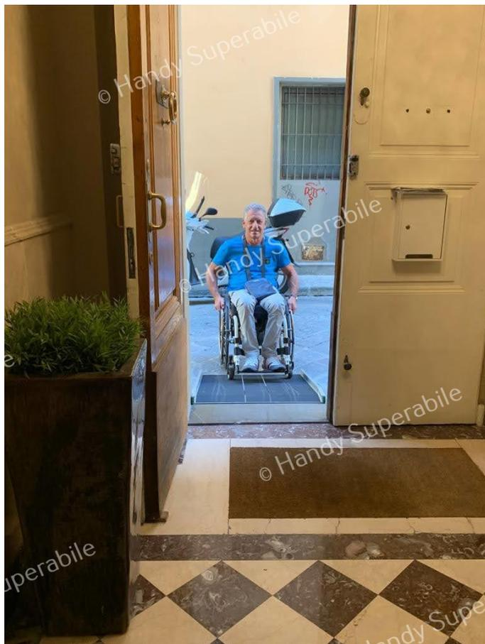
INGRESSO ESTERNO: accessibile tramite doppio scalino di 9 e 8 cm, superabile tramite rampa amovibile lunga 100 cm, larga 77 cm.
